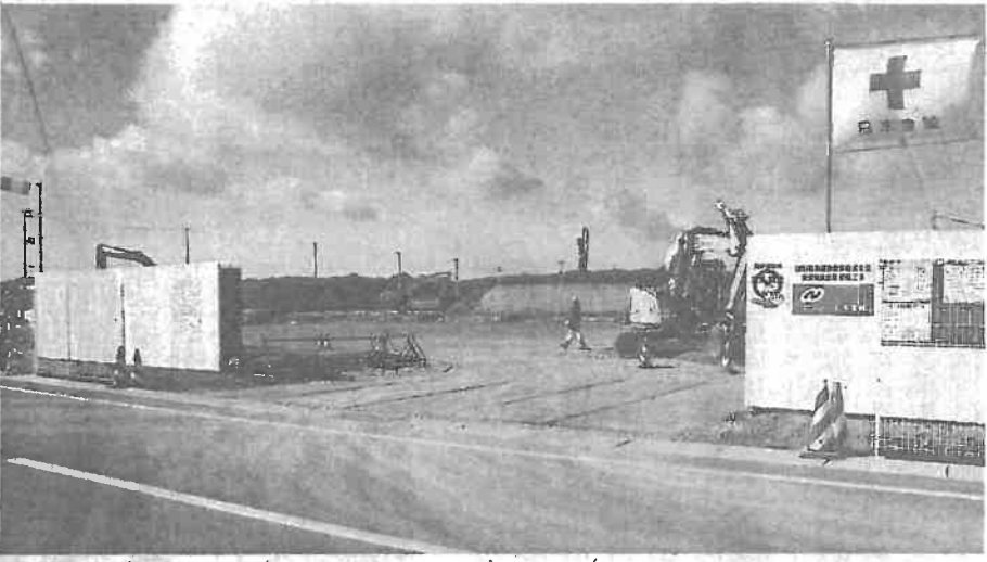
昨年11月に着工しており、今年7月に完成する予定
