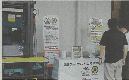
フォークリフトから電気ストープなどに電源を供給するデモンストレーションの様子＝2022年、いずれも仙台市、協和運輸倉庫提供
